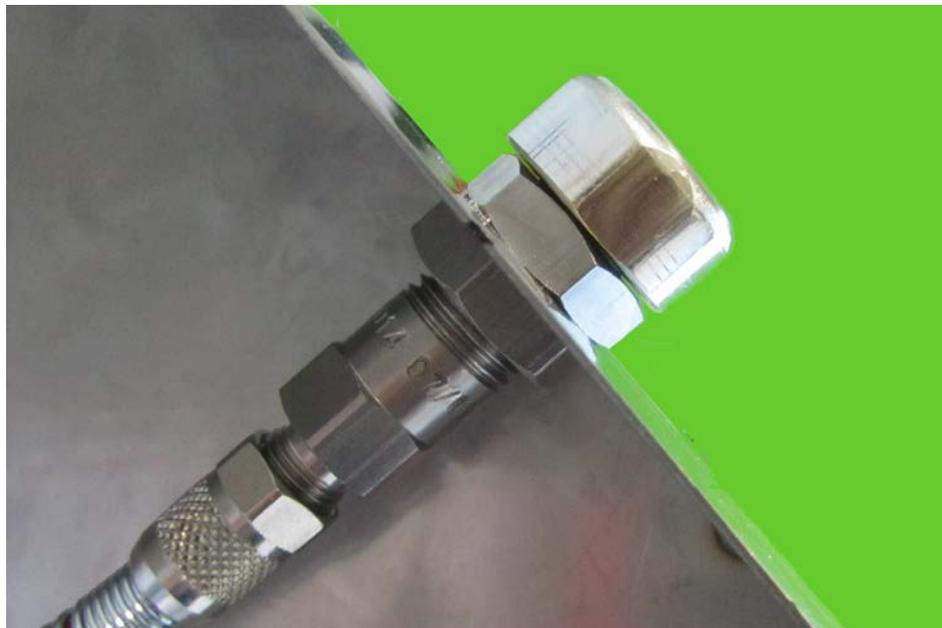
18. Une fois vérifié qu'il n'y a aucune fuite dans la tuyauterie de détection, ouvrez la clé de sécurité de la vanne du cylindre en la fixant en position vertical.
