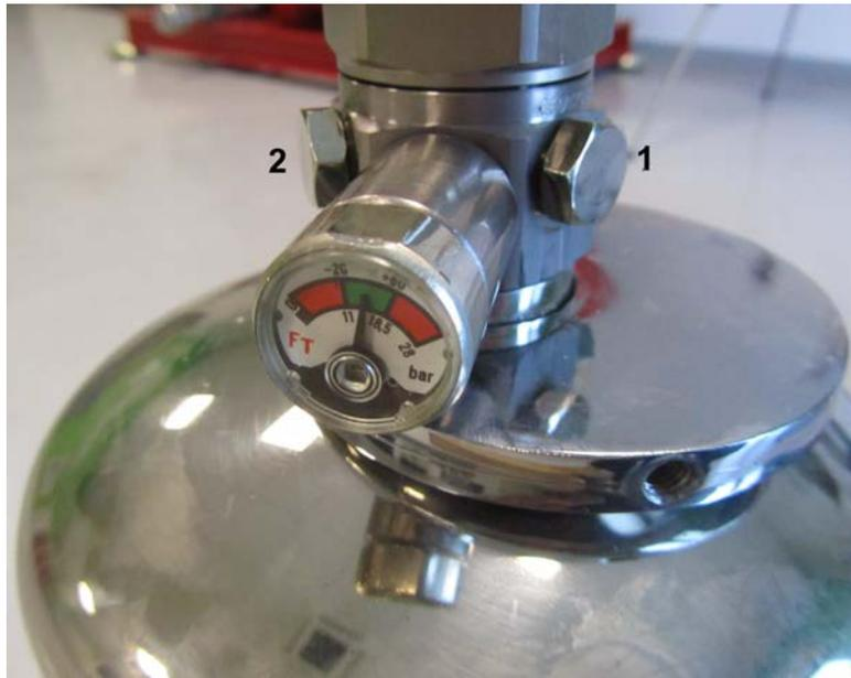
4. Enlevez le bouchon de la sortie sélectionnée et connectez dans cette sortie l'adaptateur pour la connexion de la tuyauterie à la vanne fournie:
