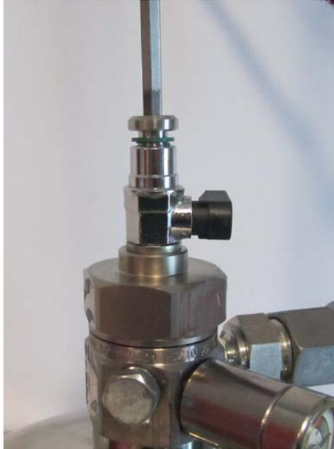
10. Connectez l'accessoire de connexion de la tuyauterie de détection.
