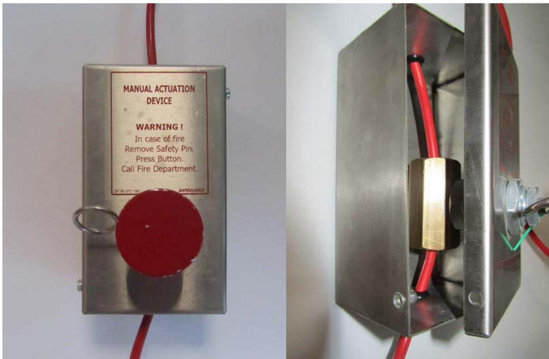
14. L'installation du bouton poussoir avec switch de control apparaît sur le dessin suivant :
