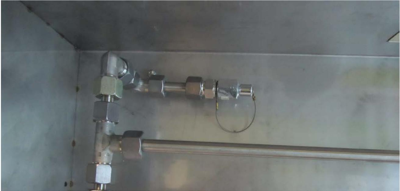
8. Dans l'ensemble est fourni un passe-mur avec un bouchon final pour la tuyauterie d'extinction, valide pour tenir le bout de la tuyauterie à la hotte aspirante. De cette manière donne de la rigidité à la tuyauterie.
